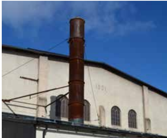
Martinverkets karaktäristiska fasad mot älven.
