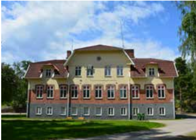
Byggnad som tidigare användes som kontor.
