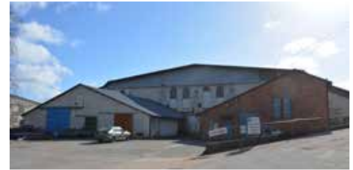
Martinverket med tillbyggnader (nu rivna).
